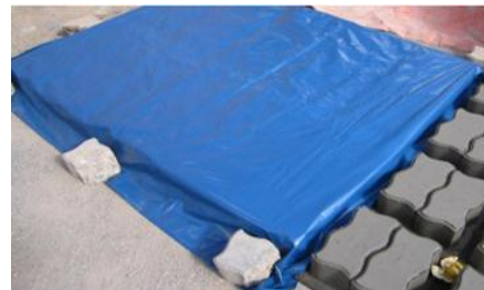
Fotografía N° 8: Losetas protegidas durante las primeras horas
