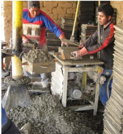
Fotografía N° 1: Colocación del hormigón sobre los moldes y vibrado
