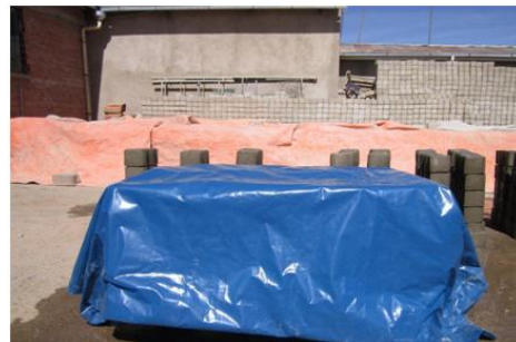
Fotografía N° 9: Losetas protegidas después del riego
