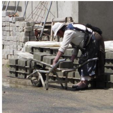
Fotografía N° 4: Apilado de losetas para el fraguado
